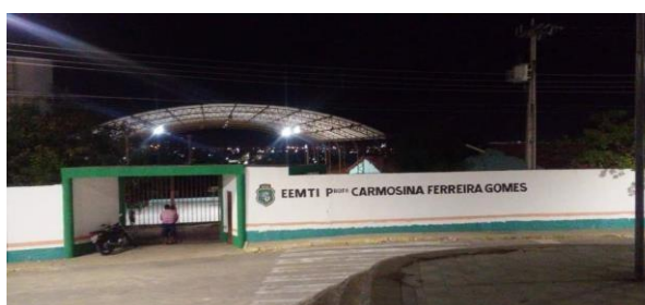
Figura 6 - Fachada da EEMTI Carmosina Ferreira Gomes
