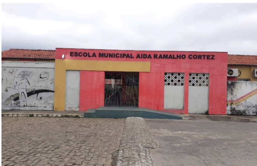
Figura 15 – Escola Municipal Aída Ramalho Cortez, Campo Redondo/RN
